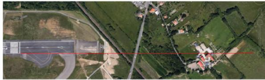
Extension complète sur 420 m de la rampe d'approche lumineuse QFU 21 à NA.
