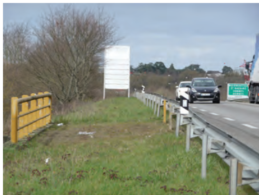
Dégagement existant sur le côté du pont SNCF.
