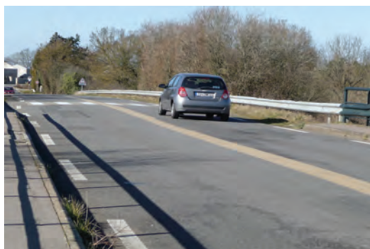
Le pont SNCF : trop étroit, la mise en place d'une ligne de tramway exigerait d'importants travaux.
